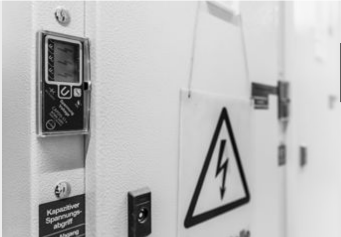
Luffisolierte MS-Schaltanlage Spannungsprüfsystem Air insulated MV switchgear Voltage testing system
